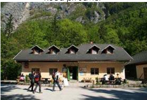
Kuća pri Savici
